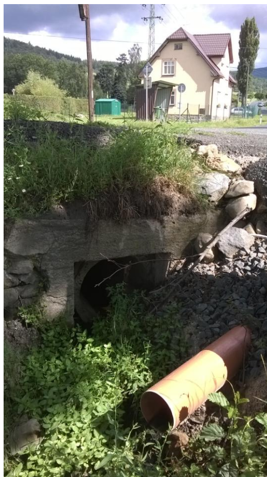
Vyústění DN 400 (bezejmenného přítoku Vitického potoka
